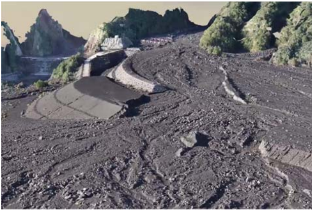
図4 桜島砂防堰堤
